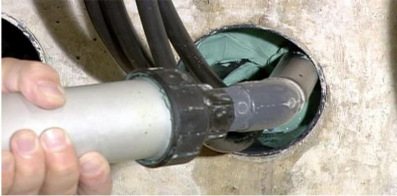
2. 지하 내부에서만 접근이 가능하여 아쿠아 스탑 2100과 몰탈 FR을 사용하여 강력한 수밀성을 구현하였습니다. 수도관, 스프링클러 시스템 및 전기 케이블을 포함한 타설 및 코어 배관 서비스와 케이블 덕트의 혼합이 밀봉되었습니다.
